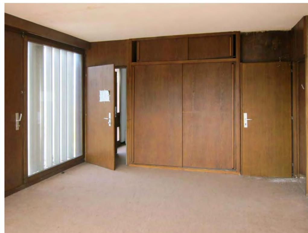
Ensemble portes et armoires avec portes coulissantes, exécution de l'ensemble en chêne
