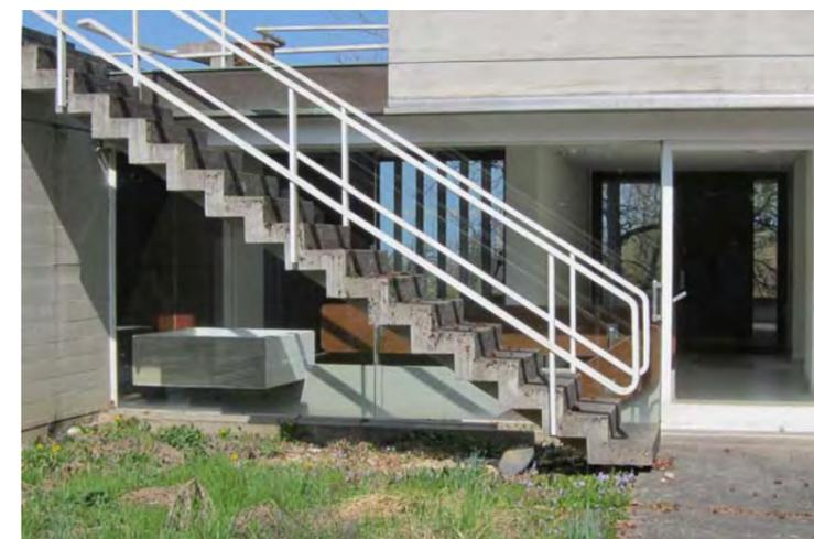
Escalier droit sur limon central, ruban de béton plié détaché du sol
