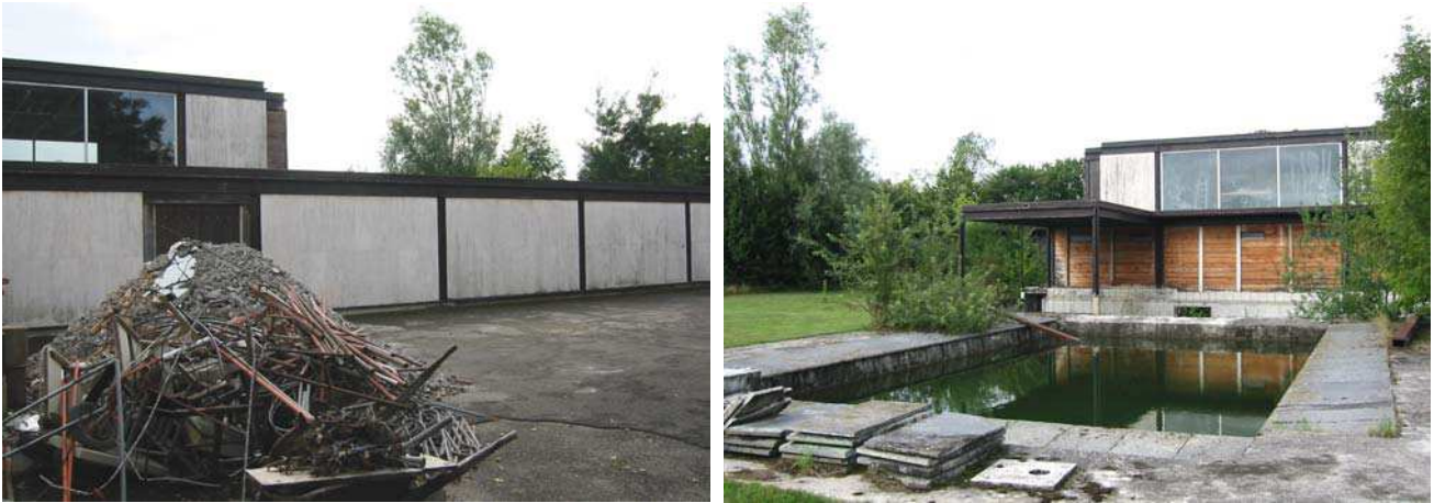
Villa Aumas réalisée entre 1965-1968 par J.-M. Lamunière (photos I. Claden 2002)
