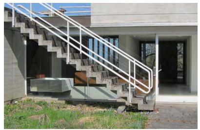
Escalier droit sur limon central, ruban de béton plié détaché du sol
