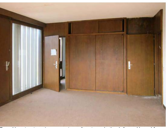
Ensemble portes et armoires avec portes coulissantes, exécution de l'ensemble en chêne
