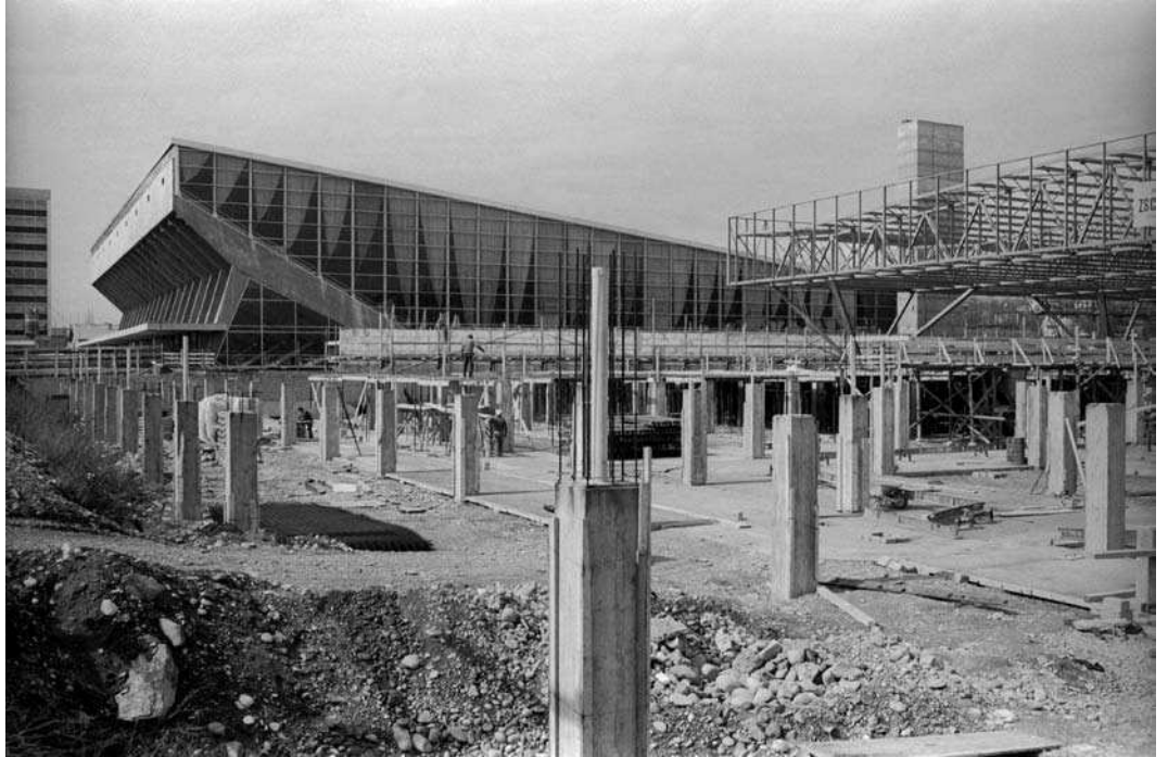
Le sous-sol du bâtiment de la piscine en construction, en arrière-plan la patinoire. (Documentation photographique – Ville de Genève, photo: G. Néri, 1965, ref. 17264)
