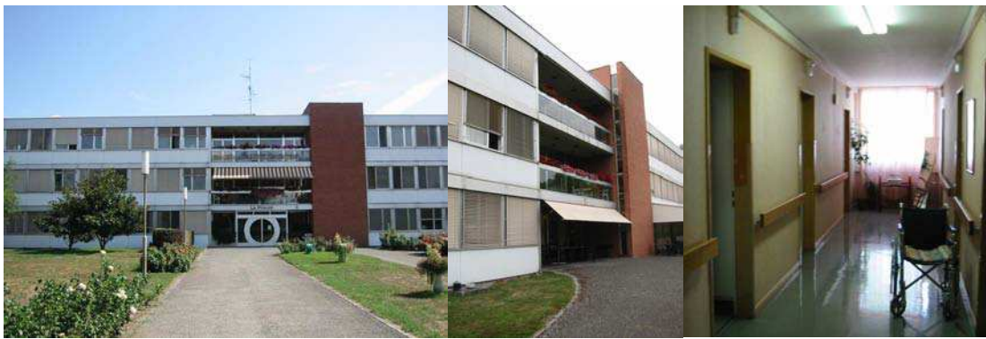
Bâtiment principal: entrée du Prieuré avec nouveau sas, lampadaires, détail cage escalier et loggia, couloir
