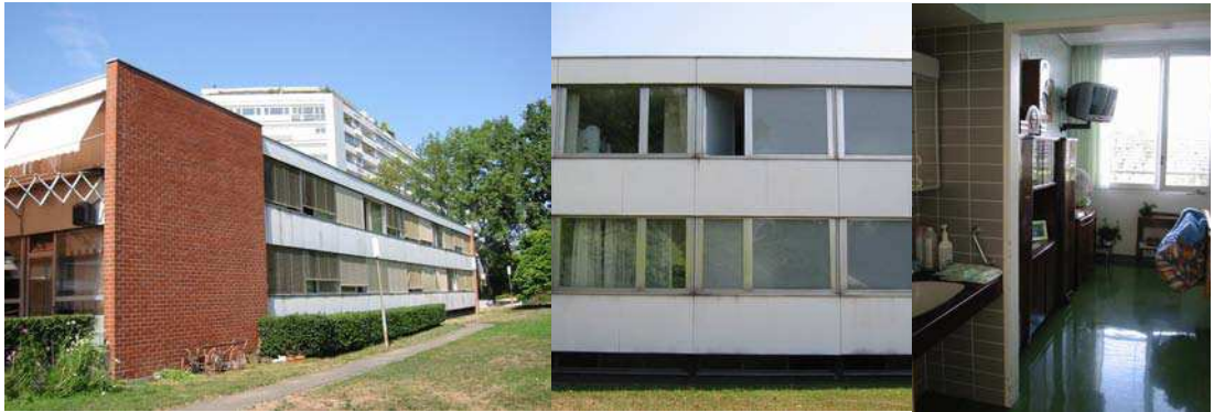
Bâtiment des infirmières renommé pavillon Alice Bodmer: fenêtres aluminium, cc en éternit, aménagement chambre
