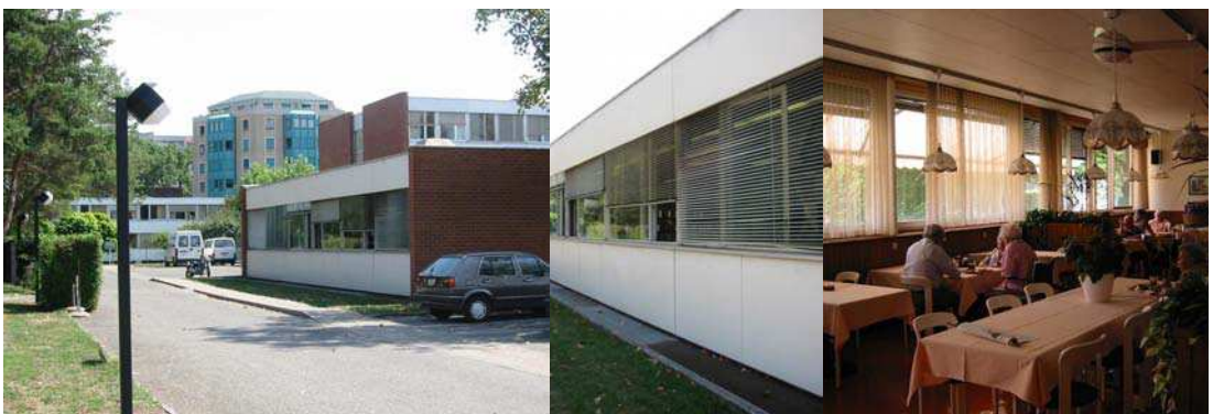
Bâtiment des services généraux: accès de service, aménagement cafétéria dans l'ancienne buanderie
